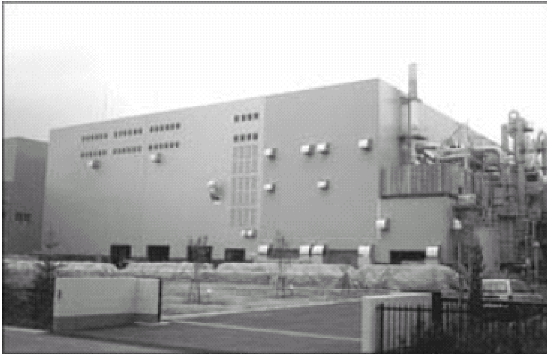
札幌プラスチック（株） 油化处理施設
