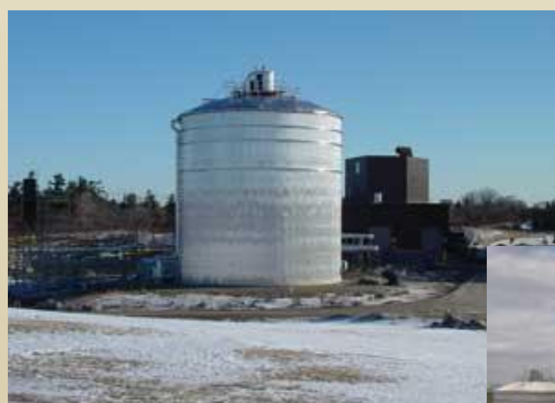
DOPF Anaerobic Digester
