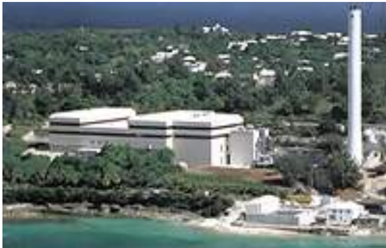
FIGURA 65 INSTALACIÓN TYNES BAY DE TRATAMIENTO DE RESIDUOS 87 (EEC)
