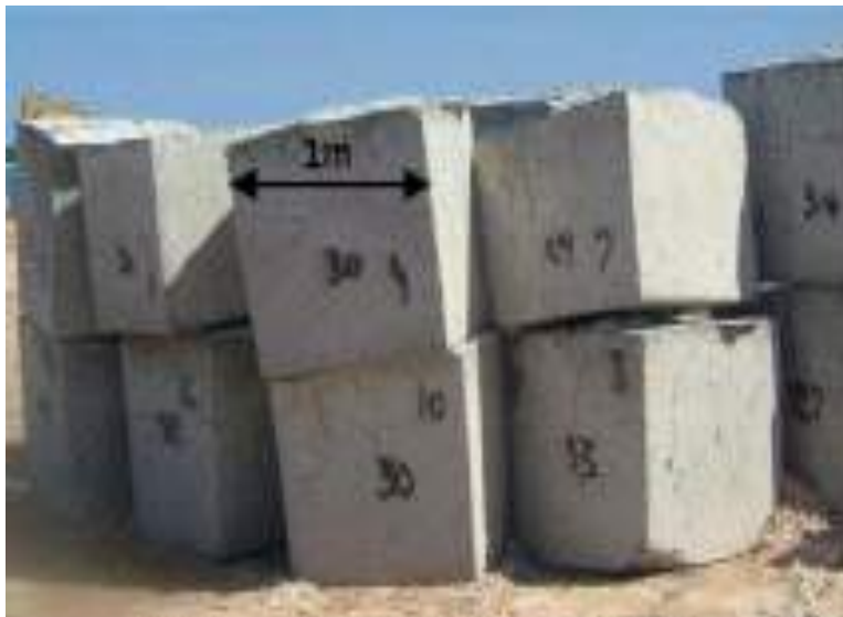
FIGURA 36 BLOQUES DE HORMIGÓN A BASE DE CENIZAS WTE UTILIZADOS PARA PROTECCIÓN DE LA COSTA Y LA RECUPERACIÓN DE TIERRAS 35
